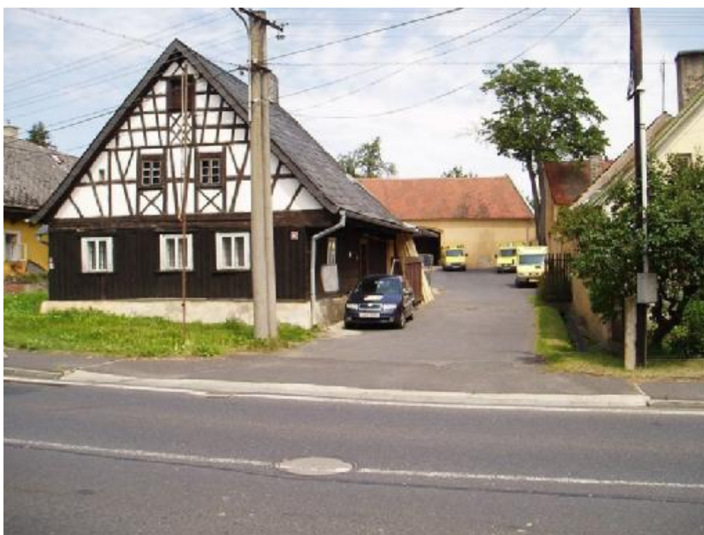
Historická hrázděnka je v evidenci památek chebského muzea. Nejdříve tu bydlela rodina Hanusových, pak zde byly kanceláře JZD, ubytovna pro zaměstnance, klubovna, nyní objekt využívá společnost Family Frost, která rozvází mražené výrobky po celém okrese
