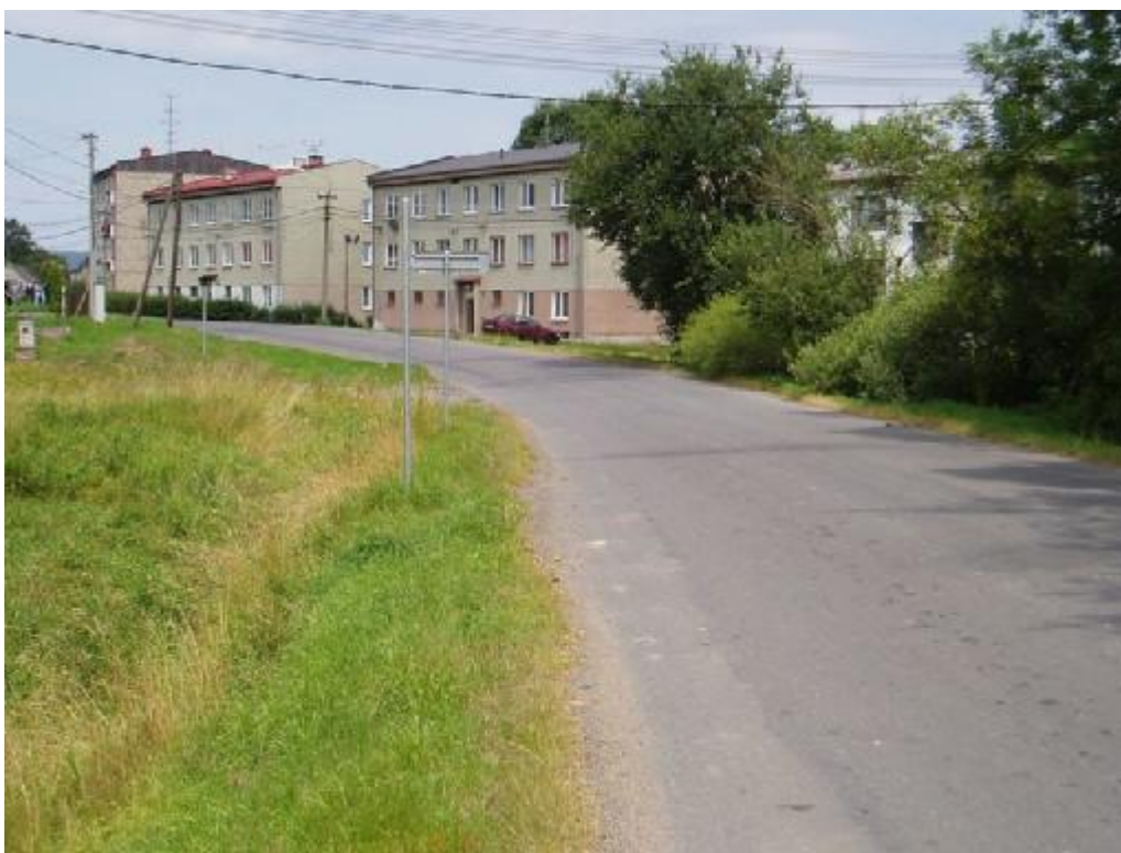
Pohled na paneláky a na příjezd do vsi ze strany od zadního Chodova, resp. Horní Vsi
