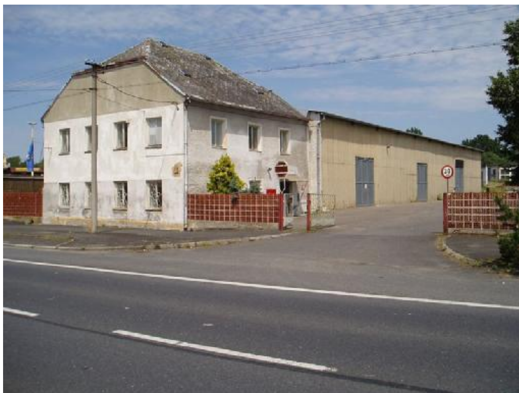
Původně budova strojní a traktorové stanice Cheb, která byla spolu s JZD jedinými zaměstnavateli ve vesnici. Po roce 1989 ji převzal privatizačním projektem pan Vladimír Černík, který je i současným vedoucím
