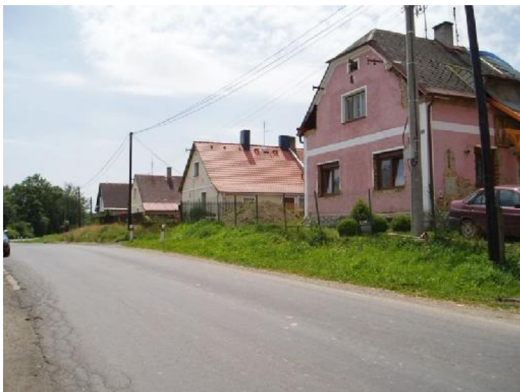
Dům rodiny Muškových je právě v přestavbě.
