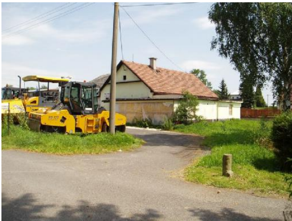
Pohled na „prodejnu“ ze zadní strany. V této době v obci probíhala rozsáhlejší oprava vozovky, proto ono zátíší se silničními stroji
