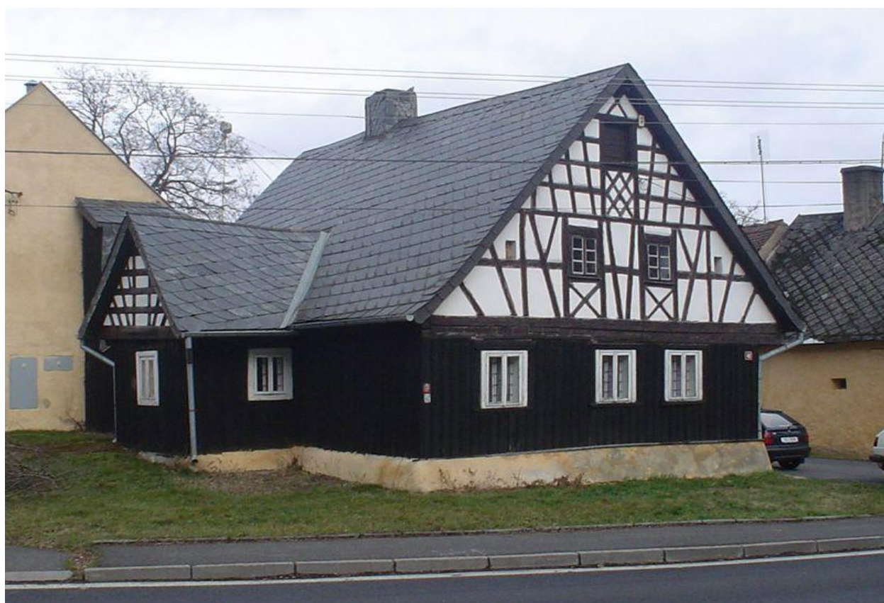
a dále za TopCarem a Antikem stará hrázděnka, která je chráněnou památkou. Momentálně v ní má sídlo společnost FROST, která rozvází mražené výrobky po okrese.
