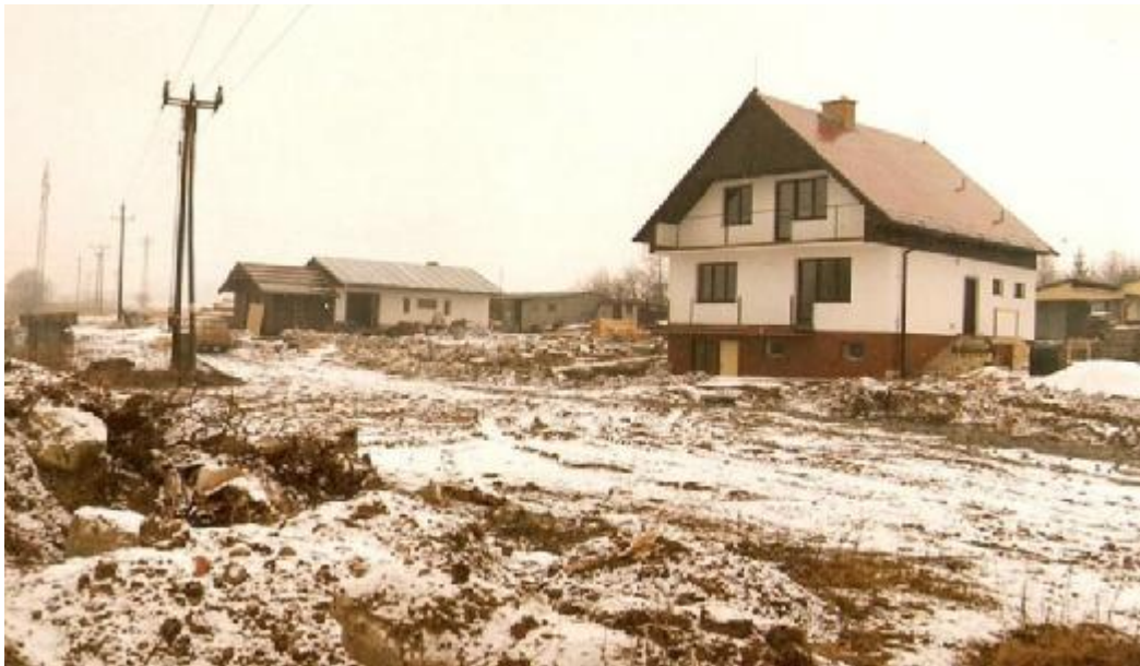
Rozestavěný objekt pily pana Königa v Trstěnicích
