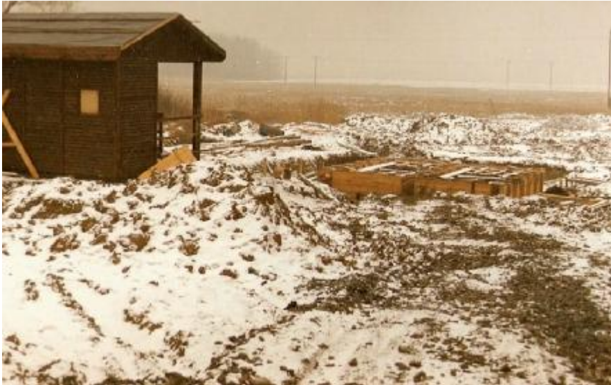
Zahajovací práce na čistírně odpadních vod
