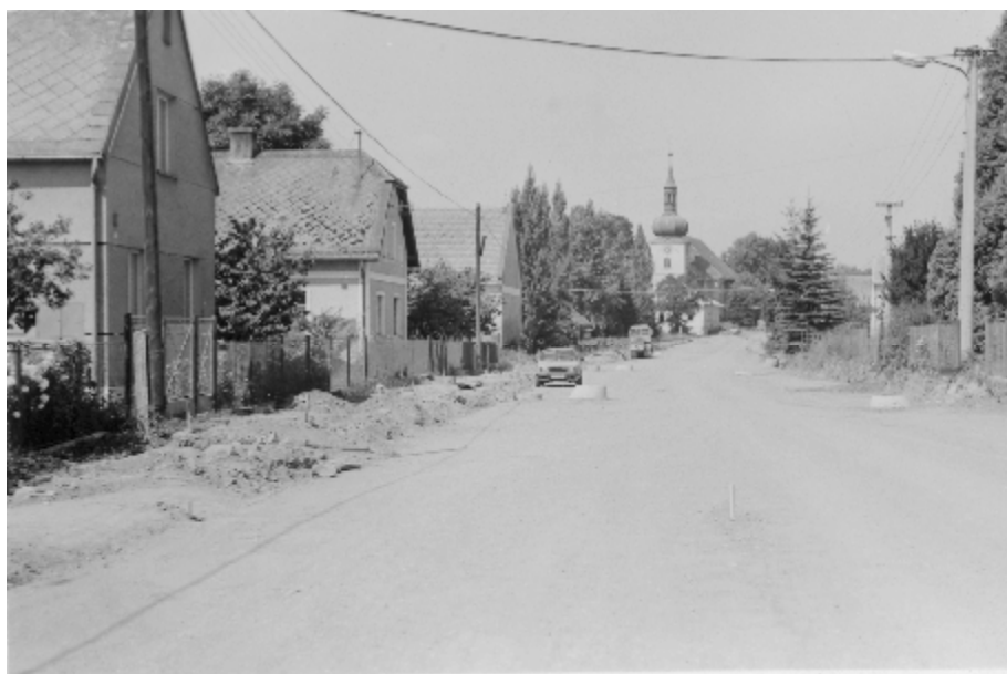
Rekonstrukce kanalizace, vozovky a chodníků v obci
