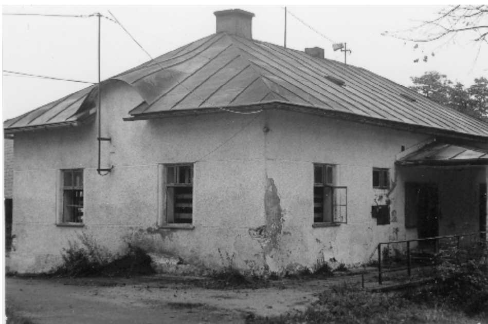
Bývalá klubovna SSM
