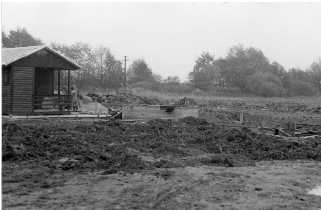
Čistička odpadních vod – práce pokračují za každého počasí
