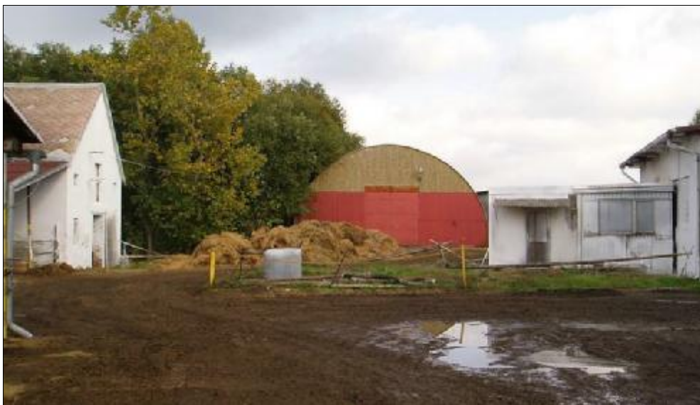
Nová kolna s ocelovou konstrukcí
