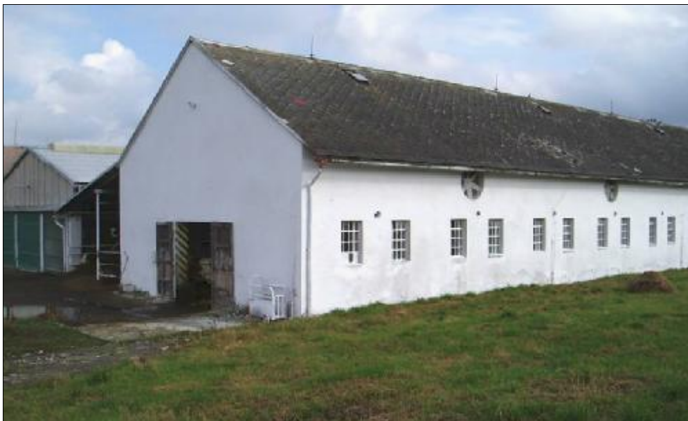
Renovovaný objekt kravína, který po modernizaci poskytuje zaměstnancům vyšší pracovní komfort
