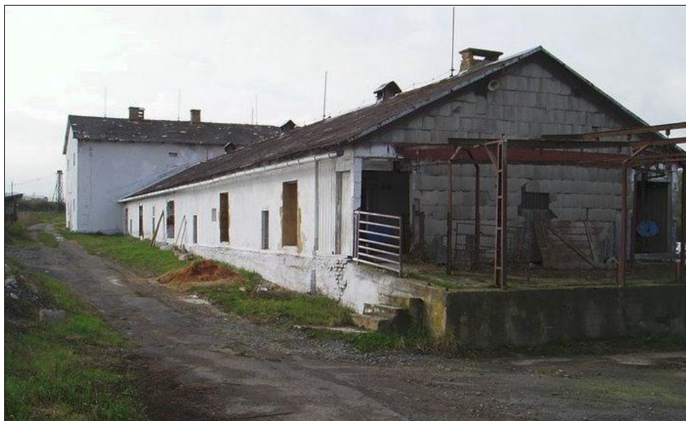
Nepoužívané stavení dřívějšího prasečáku. Po zrušení chovu prasat se pro něj hledá nové uplatnění, momentálně slouží k ubytování odstavených telátek
