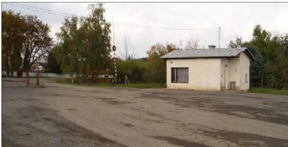
Vstupní brána do areálu ZD a vážnice se stálou službou.
