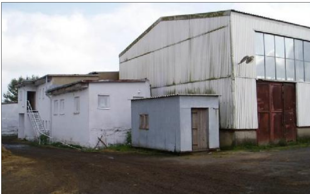
Hospodářská budova, ve které se dříve vyráběla kostní moučka a krmné granule ze zeleného krmiva s příměsí kostní moučky
