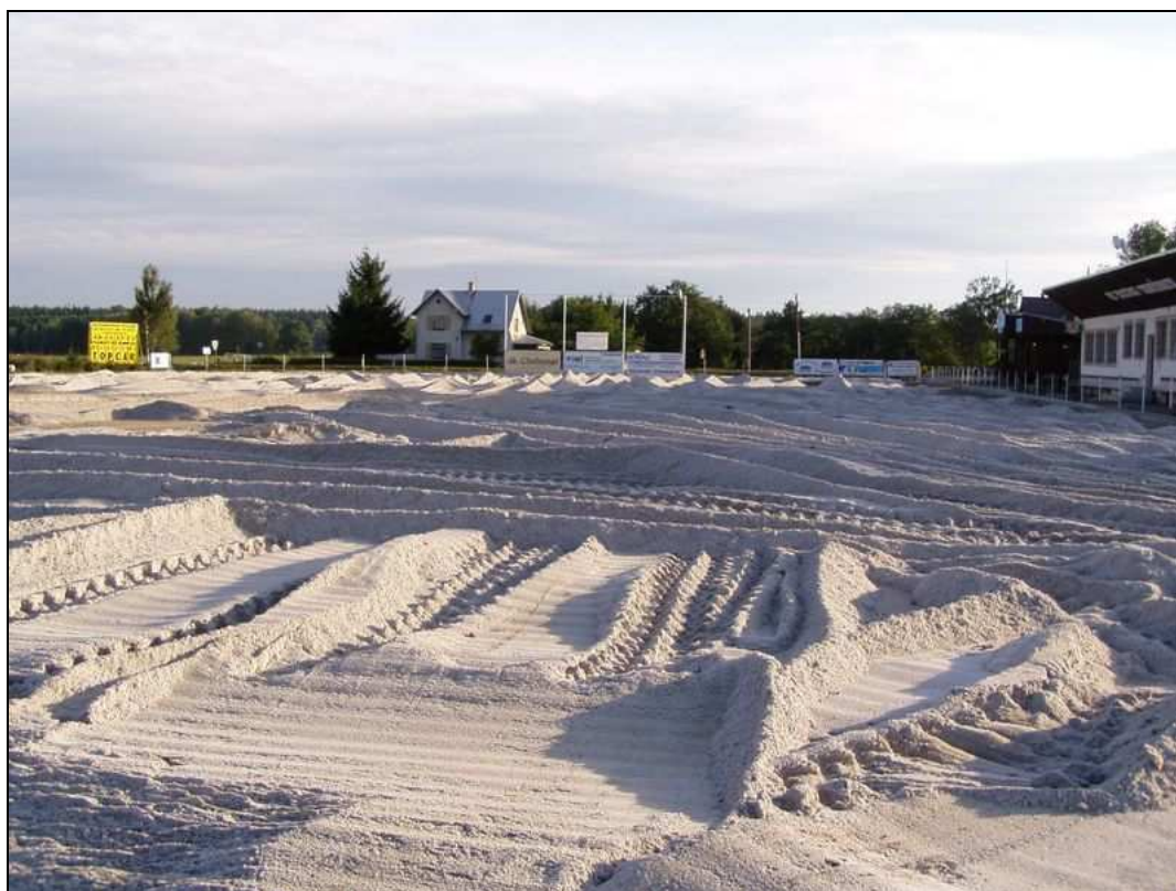
Rovnění pískového podloží 21.9.2005
