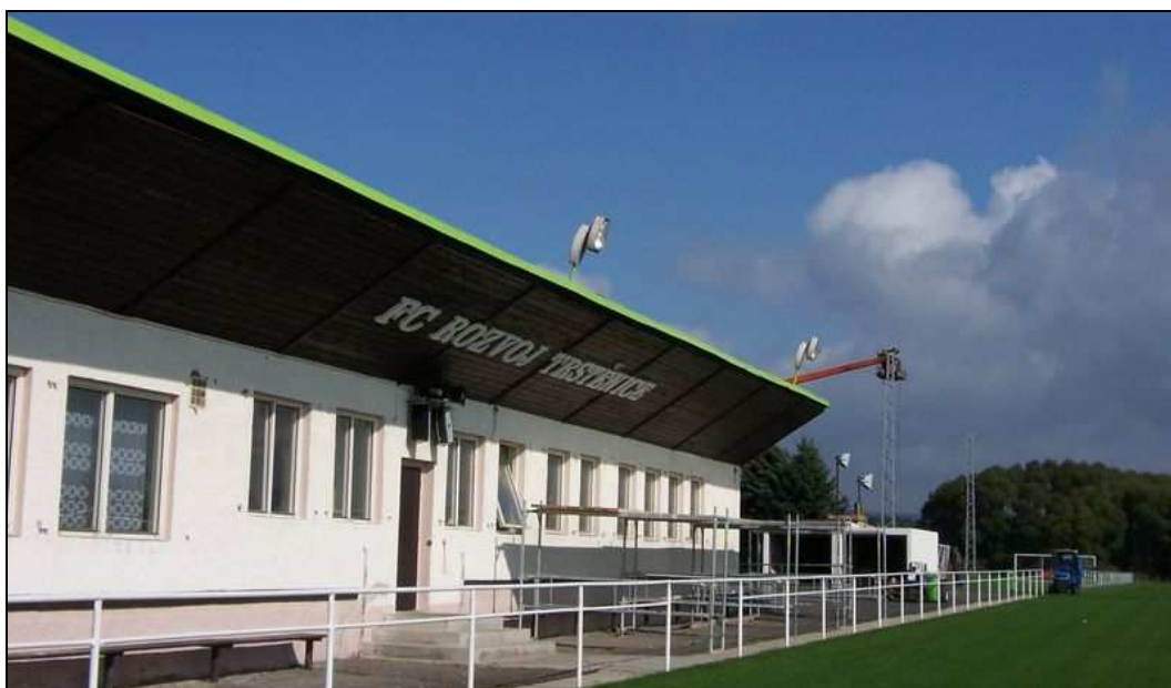
Opravy venkovní části kabin 9.8.2007:
