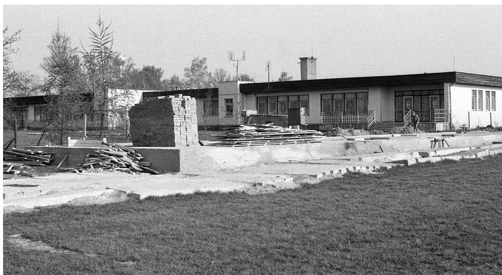
V květnu 1988 byly zahájena stavba šaten na místním fotbalovém hřišti v akci Z.
