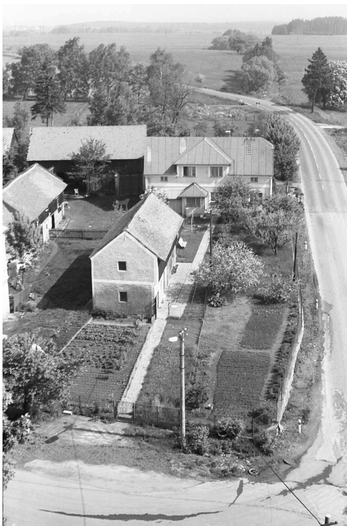
Pohled severozápadní na silnici vedoucí do Drmoulu a dále směrem na Cheb.
